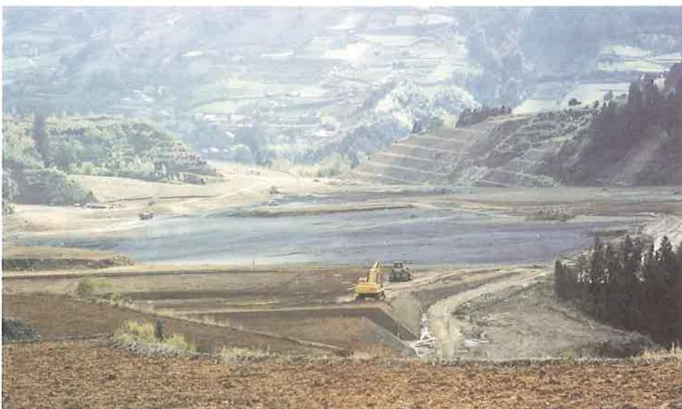
(写真中) この当たりの畑地の多くが、こういった急斜面にへばりつくように存在している。(写真下) 農林水産省の補助事業として行われている「担い手育成畑地総合整備事業」。第二東名高速道路の建設工事のトンネル掘削に当たって出た土を使って、山の谷間を埋め、57haの畑地を造成する。
