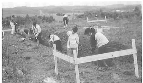
女子実習生の協力を得て、建設中の宿泊施設。ブロックは全部で1050個積む予定。
