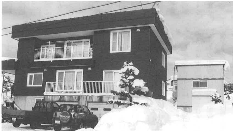
かつて畑の中に立てられていた自宅は街中に移転し、仕事と暮らしを区別した。自宅の裏には自分で立てた事務所があり、家では仕事をしない
