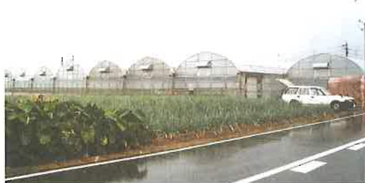
8連棟のハウス。天窗がなく、各棟の側面に換気扇の排出口が見える。
