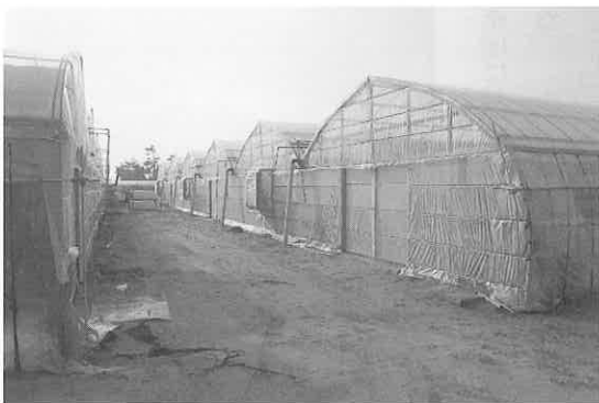
ハウスは石灰を主成分とする遮光剤（スプレー）が吹き付けられ、ハウス全体が白くなっている。夏場の温度上昇をおさえるためだ
