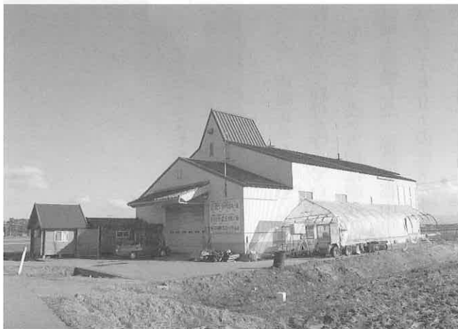
カントリーエレベータ「おもや」。米は食味が落ちないよう風力で常温乾燥する。左脇には農業研修生が寝泊りするログハウスもある
