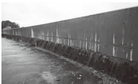
防波堤。東日本大震災で地盤が沈下し、上部の壁を増設することになった
