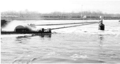
工場から排出される水はいろんなものを含んでいるので、そのまま河川に放流することはできない。池に貯溜して曝気発酵させると汚泥が沈澱する。澄んだ上水を隣の池に移し、再度曝気すると上水は浄化される。基準値に達したものを河川に放流する。
