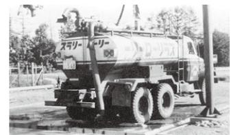
ポテトジュースは濃厚であるので、積み込み時に泡が発生する。泡を運んでは作業効率が低下するので対策しなければならなかった。泡消しに無駄な抵抗をするよりも、発生した泡を貯溜地に戻すのが時間を要さず合理的であった。特殊三方コックを開発したことにより、積み込みは円滑に行なわれた。
