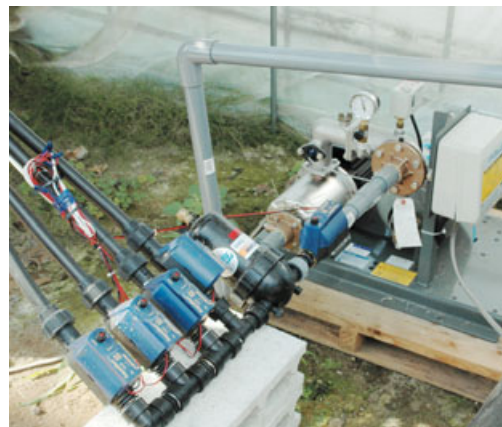
この灌水システム（ネタフィム製「アクアネット」 63 ）は、3～4 kg/cm 2 の水圧で細霧を発生させることができ、コンプレッサーやステンレス配管の必要はない。そのため、導入コストは国産メーカーの製品の半額程度に抑えることが可能。コントローラー（ネタフィム製「ミラクルプラス」 64 ）によって自動化することができ、複雑なプログラムにも対応する。これらは、會田氏がイスラエルの展示会にまで足を運び、見つけてきたものである。
