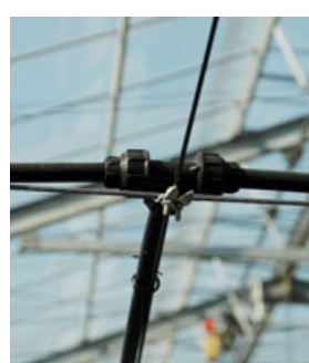
この灌水システム（ネタフィム製「アクアネット」 63 ）は、3～4 kg/cm 2 の水圧で細霧を発生させることができ、コンプレッサーやステンレス配管の必要はない。そのため、導入コストは国産メーカーの製品の半額程度に抑えることが可能。コントローラー（ネタフィム製「ミラクルプラス」 64 ）によって自動化することができ、複雑なプログラムにも対応する。これらは、會田氏がイスラエルの展示会にまで足を運び、見つけてきたものである。
