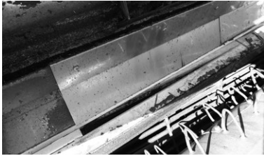
写真5：ピッタリ補修が完了した脱穀部
