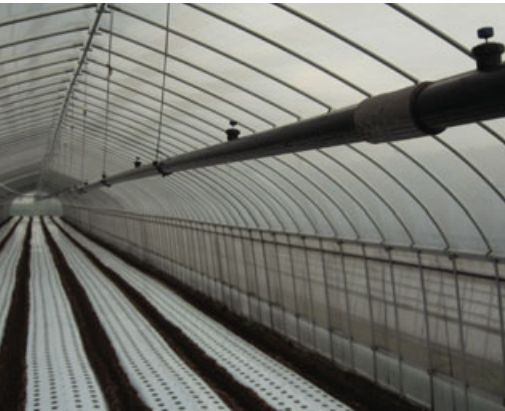
ハウスの散水装置はエルメコの頭上灌水装置 65 (丸山製作所)。水はハウスの横まで定置配管されている。
