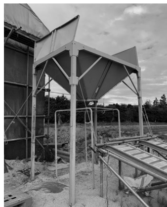
写真1: 台風で倒された粉殻タンク
