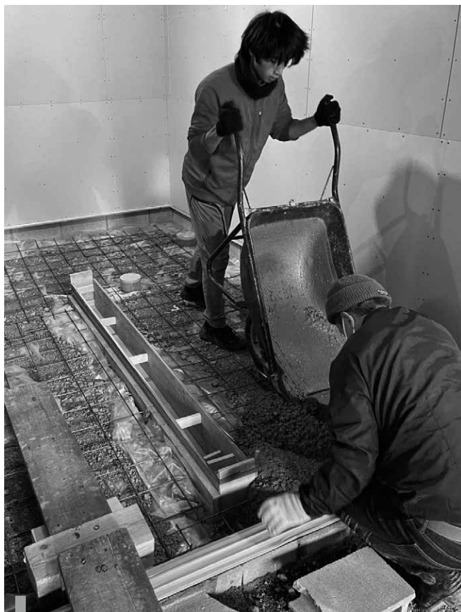
コンクリートの土間打ちも経験させていただきました。
