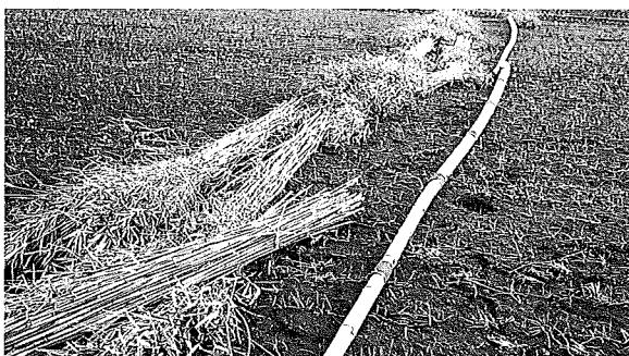
②作業のしやすさと能率を考え、暗渠施工位置の横には、あらかじめモウソウチクとシノダケの束を置いてある。モウソウチクは節が落とされ、集水穴を開けた後に重ね合わせて、管となっている。
