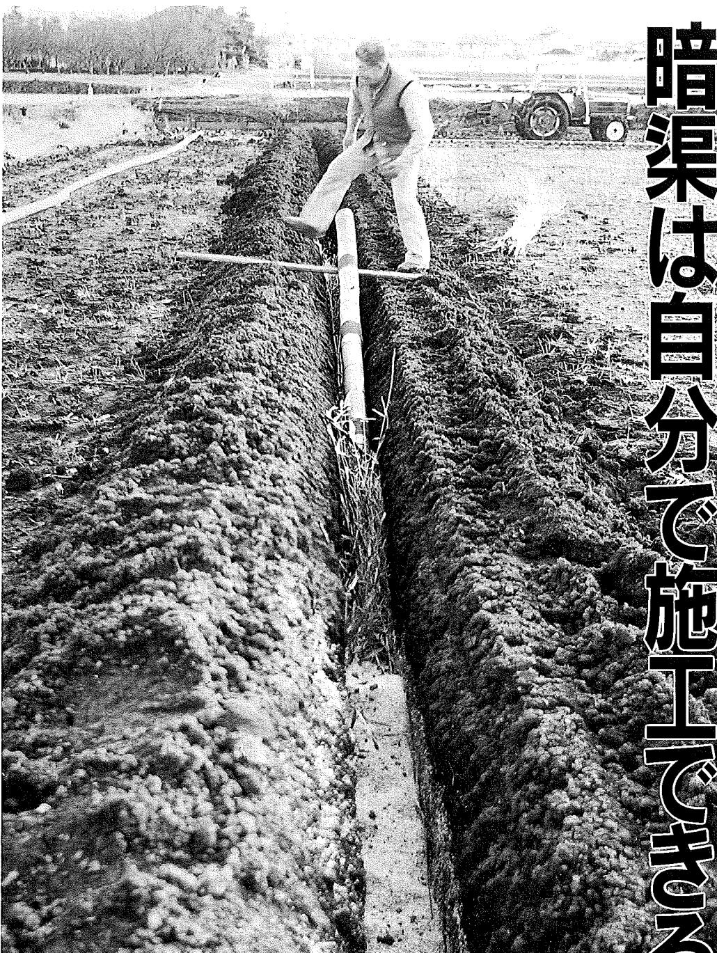
①モウソウチク暗渠の作業風景。奥のトラクターに装着したトレッセラーで細い溝を掘っていく。排水溝に通じるこの溝は、すでに暗渠管の埋設まで進んでいるが、奥の溝はまだ掘られていない。
