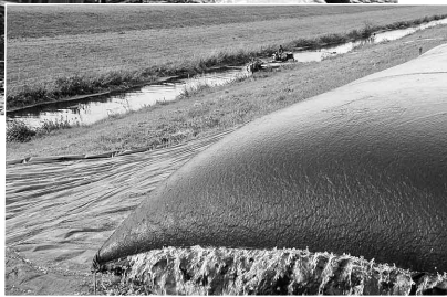
浚渫船が汲みあげた堆積物は袋ごと乾燥させた後で切開、中身はトレーラーに積んで運ぶ。
