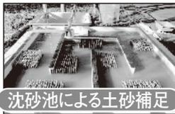
沈砂池による土砂補足
