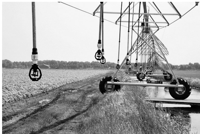
パワー社の灌漑システムは走行範囲の終点に来ると、給水用の用水路を超える必要がある。車輪が斜めに仮設ブリッジを横断している。
