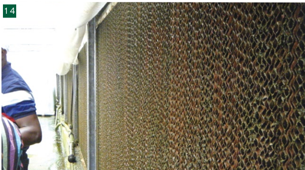
⑪ 気象データを読み取るウエザー・ステーション。データは農場管理事務所のサーバーに転送される⑫⑬⑭ランの栽培で使われていたラジエータ式ヒートポンプと細霧灌水システム。反対側に換気扇を設置し、空気を外に引っ張る。ハウス内は外気に比べ5、6度低い25度を維持していた。⑮イスラエルのワイン用ブドウ生産者が集う「Israel Wine Grape Board」の展示ブース。同じ品目の業界が一体となって、技術課題の解決や輸出マーケティングを行なっている。
