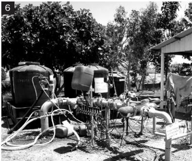
5 生食用のブドウ畑。ネットの種類（白・赤・黒・ポリフィルム）や品種を選ぶことにより9ヶ月間（5月から1月まで）出荷する。6 今回視察した圃場にはほとんど設置されていた点滴灌漑システムの装置（養液タンク、ホンプ、フィルター）。これらのシステムが気象情報、土壌水分などのデータから最適なタイミングで自動的に作動する。7 切花の出荷作業をしている外国人労働者。タイ人が多いらしい。8 ネタフィム社製のガラスハウス。点滴チューブから始まった同社もグローバル経営になり資金・技術力がついて自社でガラスハウスからすべて生産できるようになった。販売価格はすべて込みで1haあたり1000万ドルとさすがに高価。
