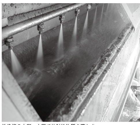
洗浄機の内部。水圧で放射性物質を落とす
