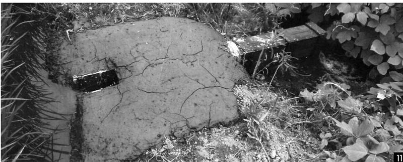
11 実際の施工事例。排水マスの底面は突き固めた砂利にする。砂利や石を詰めながら、粉セメントを振りかける。この時点では乾いた状態が望ましく、雨や排水時の水で徐々に濡れてくることで、セメントが砂利や石をいい塩梅にすなぐ役割を果たすようになる。モグラやザリガニなどの「穴開け」による排水マスの流出を防ぐ。また、水田も畦も高さが変わることがあるので、ガッチリ固めてしまうと排水マスを移動したり、壊したりする際に邪魔になってしまうのだという
