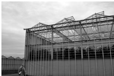
高さ7m40cm、面積8haの温室を8パートに分けて制御している。
