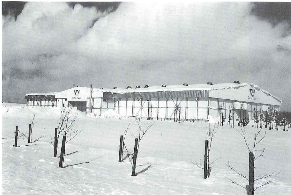
北海道美瑛町にあるカルビーポテト(株)のバレイショ貯蔵施設
