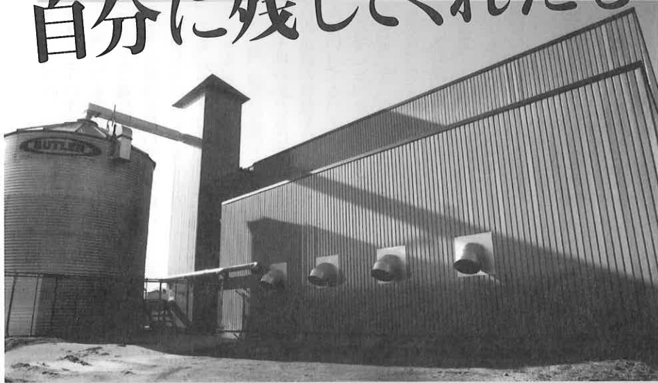
金子農機の貯留乾燥設備「ライスダム」を導入。 この設備で17%までの乾燥をし、粳のまま貯蔵。 出荷時に循環型で仕上げ乾燥をする
