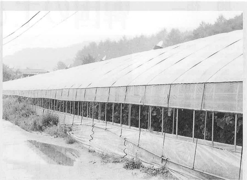
写真1 パイプハウスに天窓を取付けたもので換気に気を遣っている
